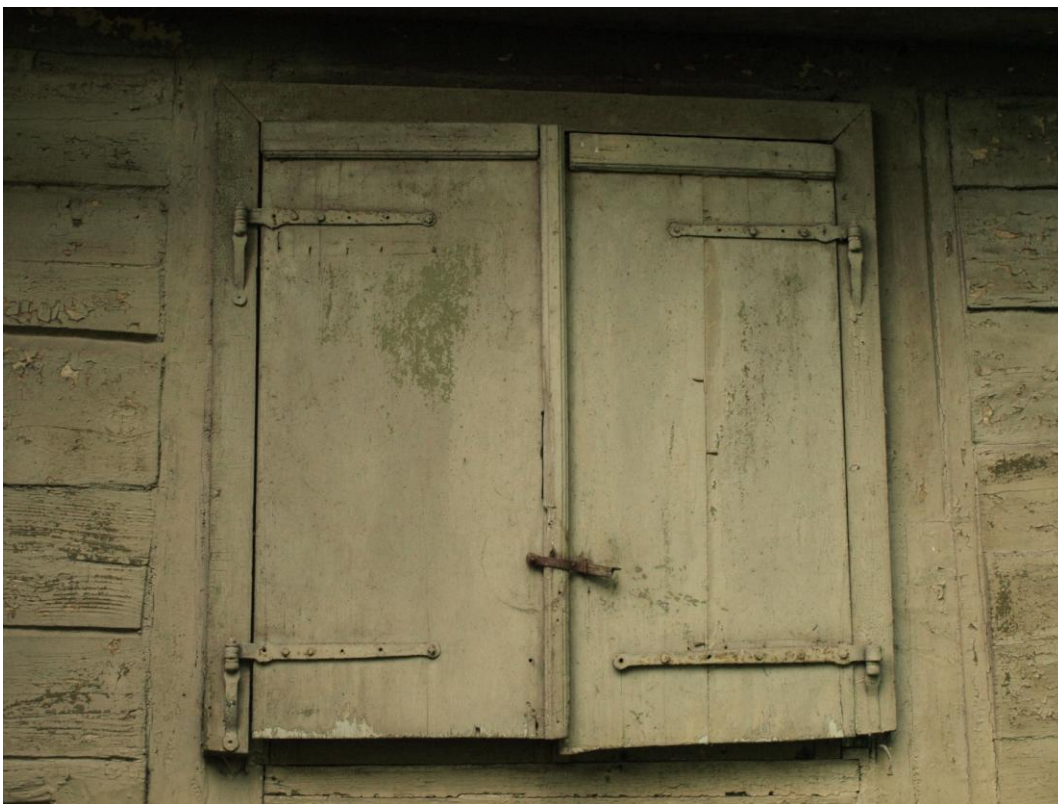
Sākotnēji (19.gs.3.cet.) slēgi ar oriģinālo aprīkojumu. Slēgi apzāģēti, apmales – 20.gs.2.puse.
