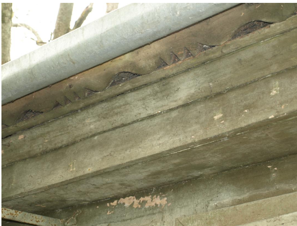
Sākotnēja (19.gs.3.cet.) dēļu dzega un kokā griezts aizsegdēlis.
