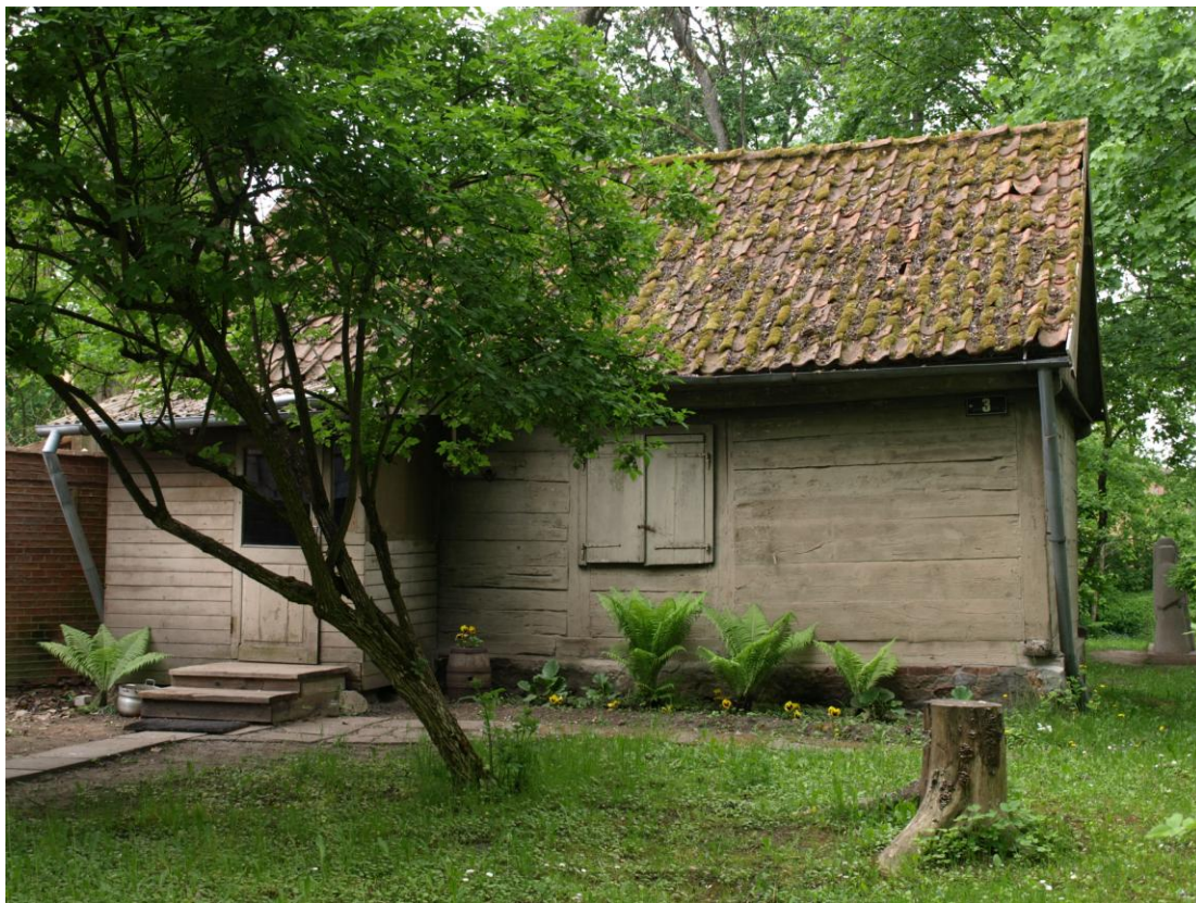
Skats uz ēku no austrumiem.
