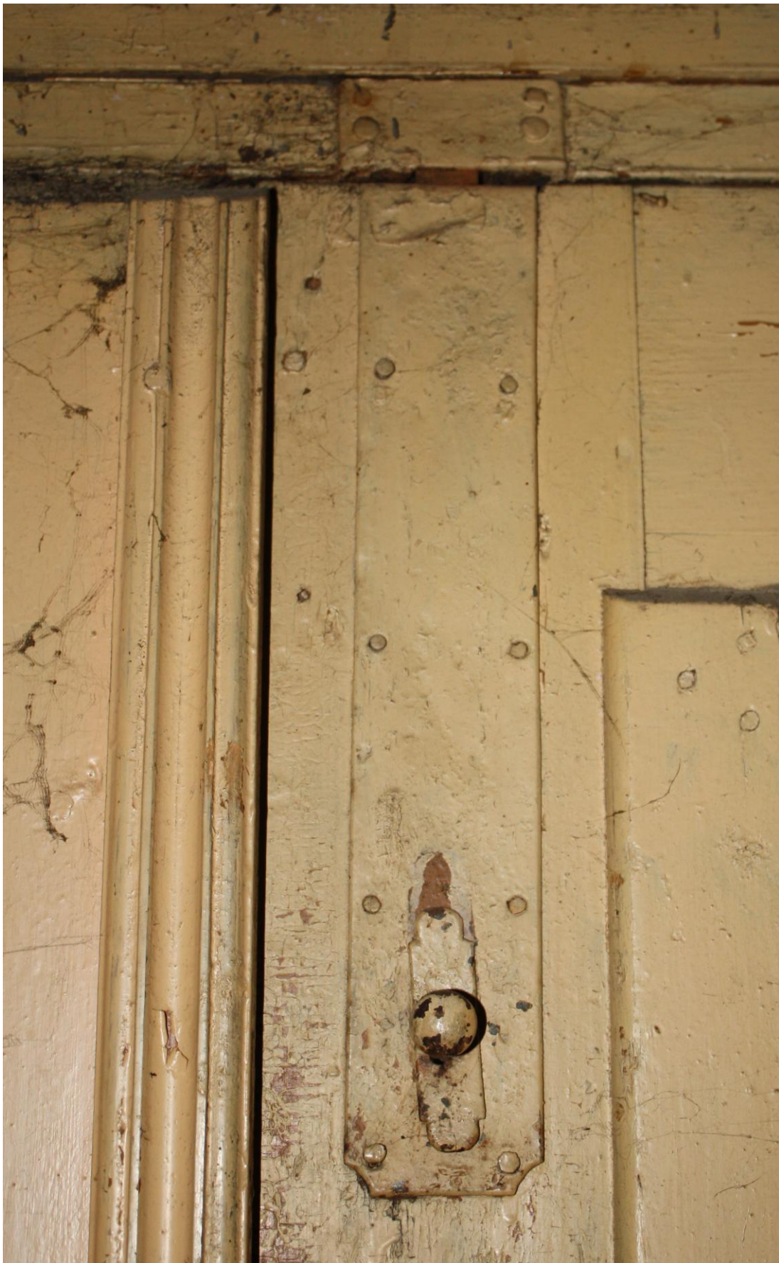
Durvju vērtnes sākotnējais augšējais fiksators (baskvils)
