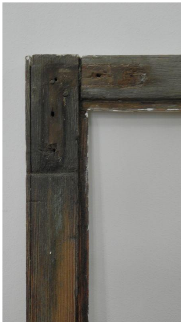
4.att. L1-1 detaļa. Vēlāk piestiprināta līstīte.
