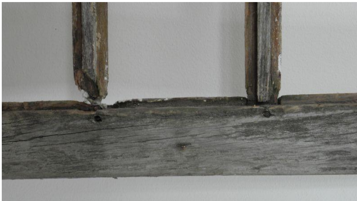
19.att. L2-3 detaļa. Spraišļi satrupējši, tie protezējami.
