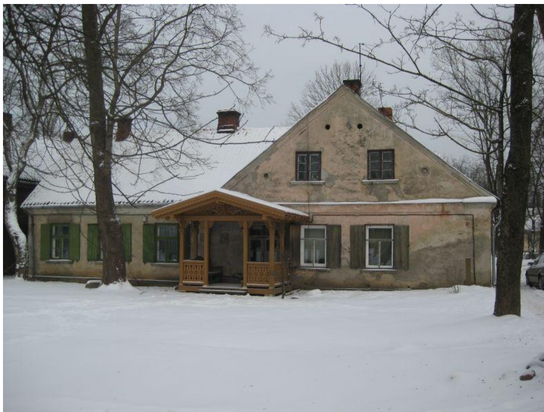
2.att. Ēkas kopskats. Fasāde pret Pētera ielu 5. 17.02.2012.
