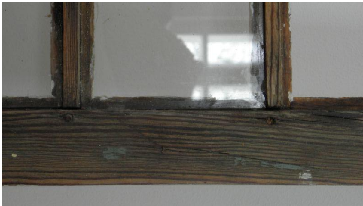
11.att. L1-3 detaļa. Stikls stiprināts ar silikonu.
