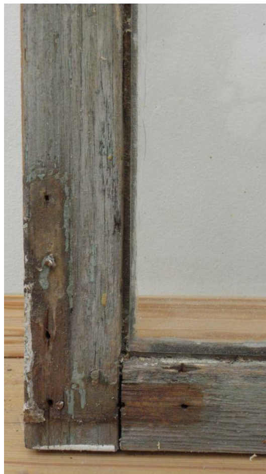
13.att. L2-1 detaļa. Rūsas traipi un krāsas pārpalikumi uz koksnes.
