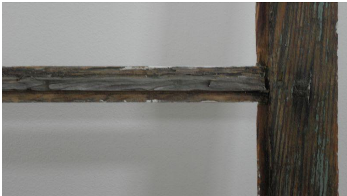
8.att. L1-2 detaļa. Spraislis protezējams.
